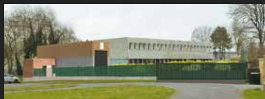
Image de la future chaufferie depuis la rue du Parc
