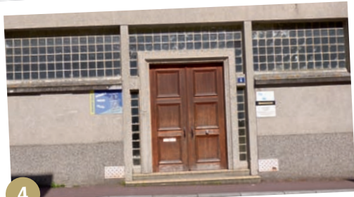
4 > Une entrée très fifties avec ses pavés de verre et ses encadrements en béton gravillonné
