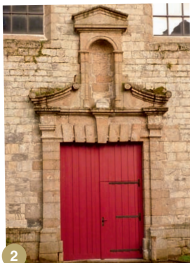
2 > Cette belle porte du 17 e siècle est celle d'un bâtiment plus ancien que l'ensemble dans lequel il se trouve...
